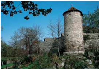
Historische Wehranlage (Hospitalturm)
