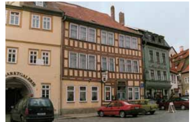
Das Hufeland-Haus in Bad Langensalza
