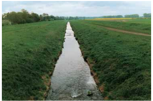
Befestigte und begradigte Unstrut: Angrenzende Orte und Felder sind vor Hochwasser geschützt.
