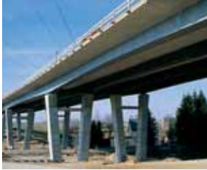
Autobahnbrücke in Röhrsdorf
